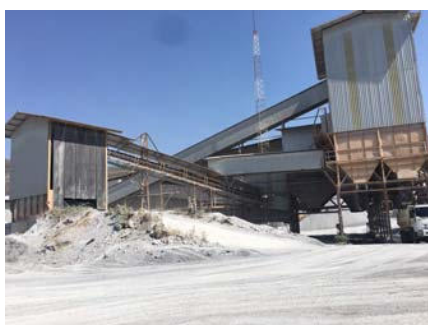
รูปที่ 2-15: การปิดคลุมอาคารโรงโม่
